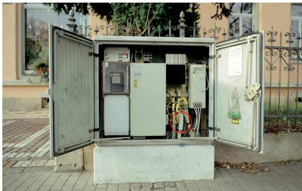
GPON-Verteiler tragen kaum auf: Neben den wuchtigen HYTAS-Komponenten von 1994 stecken unten im Schaltkasten lediglich zwei unscheinbare passive optische Splitter (flache graue Kästchen).
