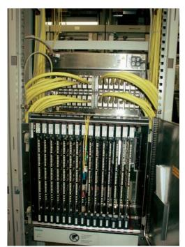
Vermittlungseinheiten, sogenannte **DSL Access** Multiplexer (DSLAM), versorgen jeweils einige **Dutzend bis** einige hundert Haushalte. Sie benötigen eine Anbindung an den Backbone per Glasfaserkabel.
